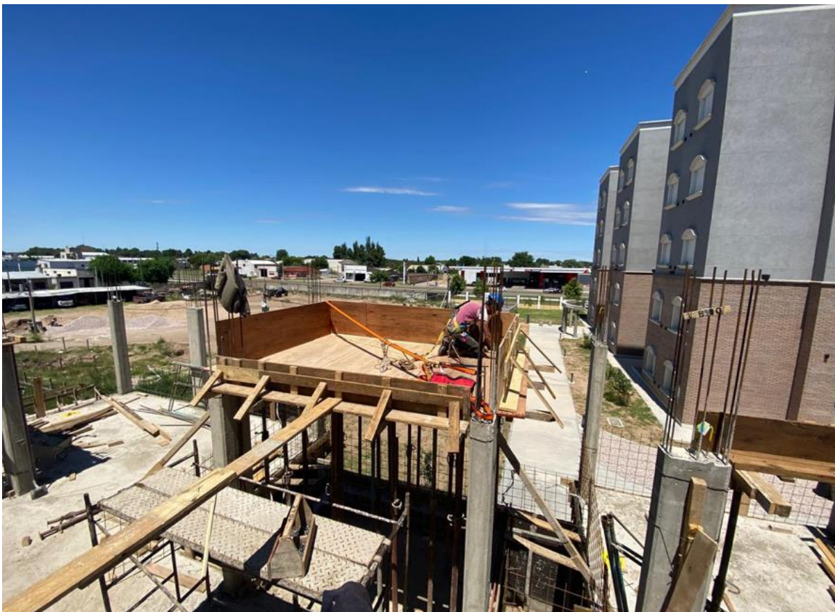
Armado de encofrados para balcón. Utilización de nuevos elementos de seguridad. LOSA SECTOR B – PRIMER PISO
