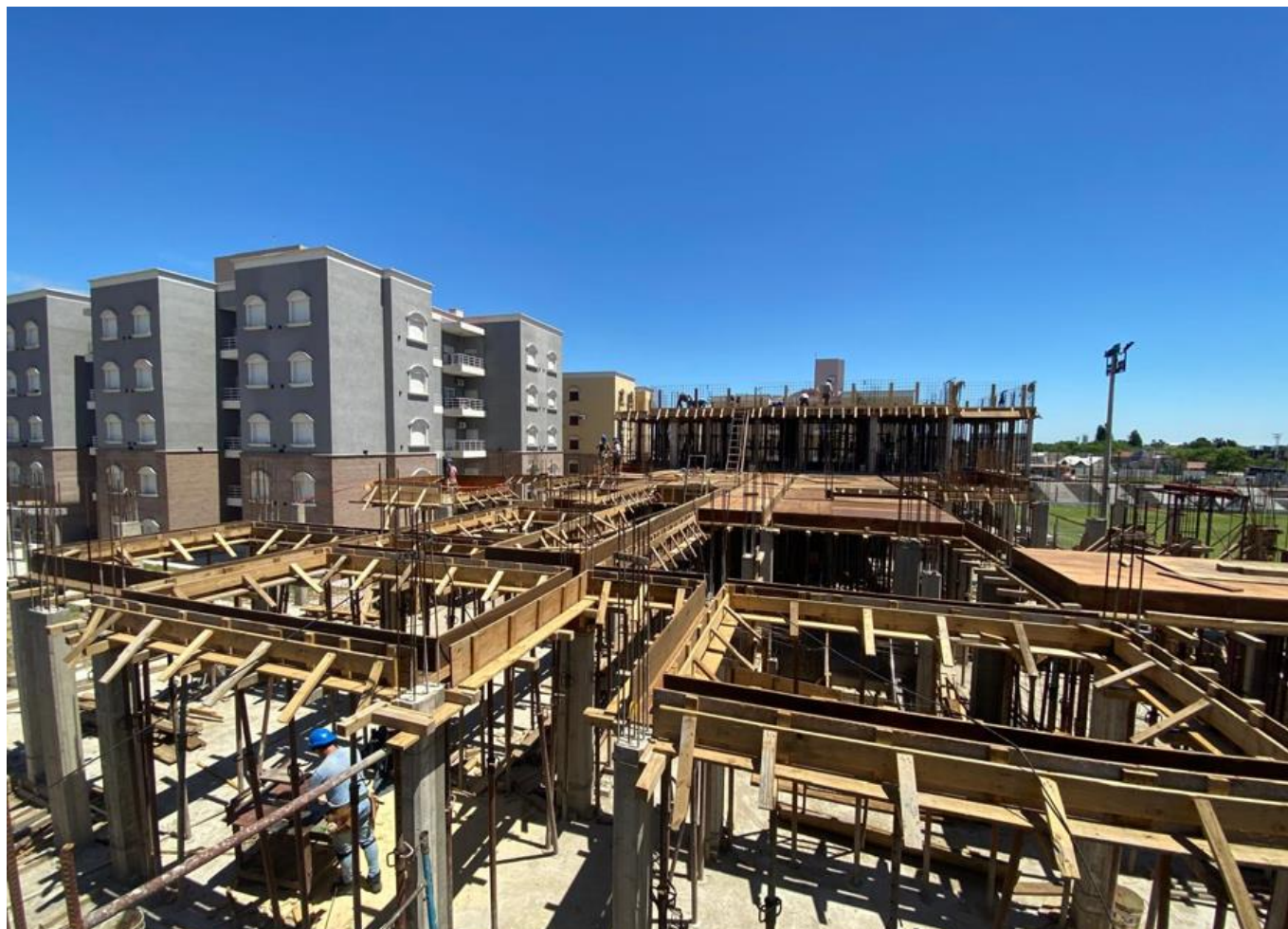
Encofrados - LOSA SECTOR B – PRIMER PISO
