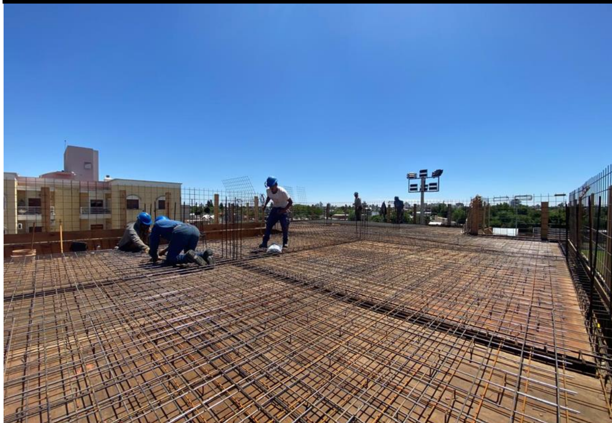
Armado de losa con encofrados y vigas. LOSA SECTOR A – SEGUNDO PISO
